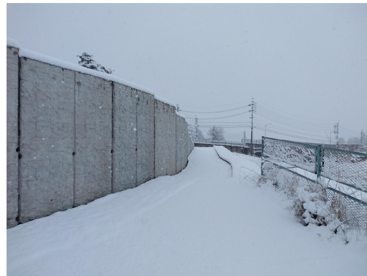
貸付地より歩行者出入口を見る
