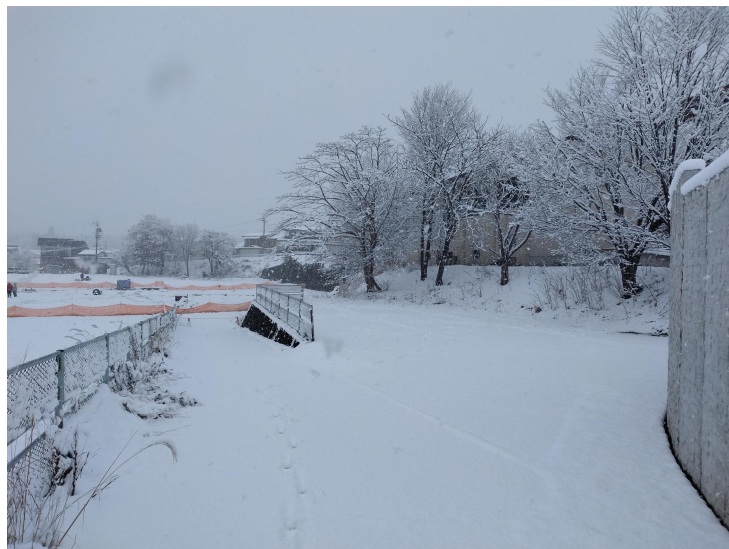
歩行者出入口より貸付地を見る
